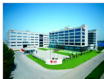
上海智慧能源产业园
